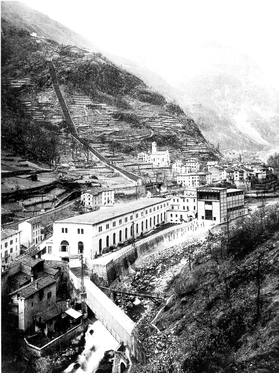
Die Zentrale Campocologno, erbaut von 1905 bis 1907. Zustand von 1928. (Conradin Clavuot, Jürg Ragetti, «Die Kraftwerkbauten im Kanton Graubünden», Chur 1991, S. 48)
