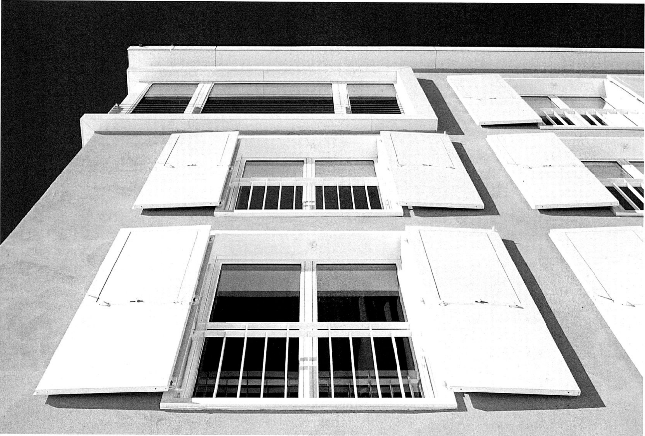
Die französischen Fenster mit weissen Metallzargen und Aluminiumläden sind streng angeordnet. (Foto: Patrick Blarer)
