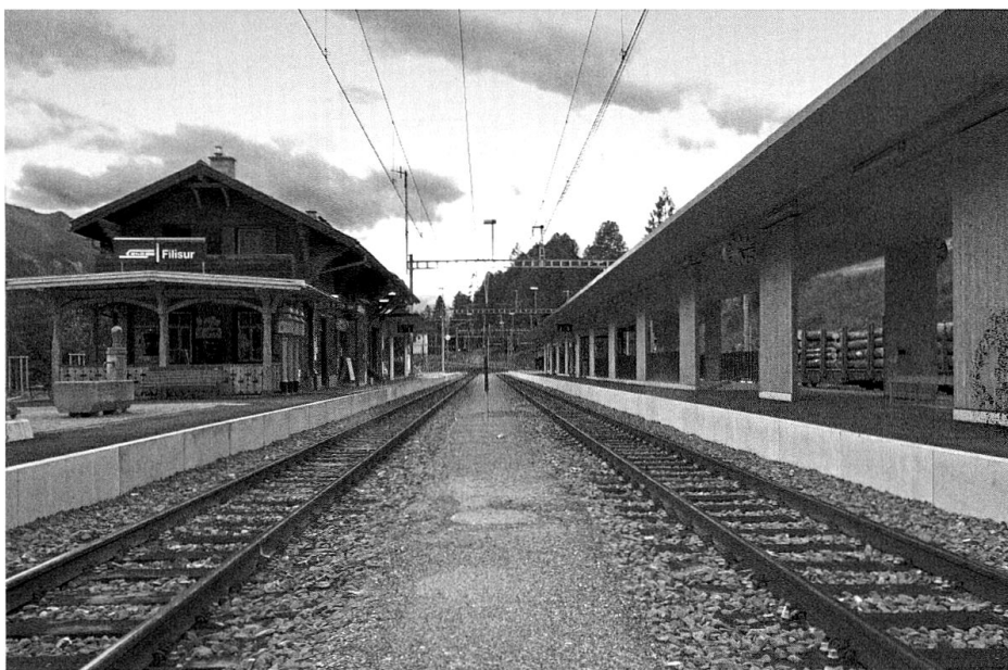
Bahnhof Filisur mit der neuen Perronanlage.
