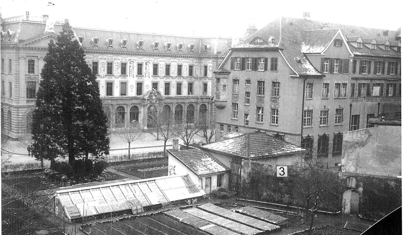
Abb. 4 Garten des Alten Gebäus mit Treibhaus/Gewächshaus und Remise.
