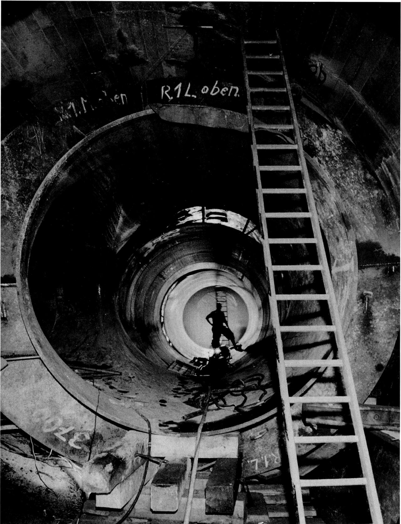
Baustelle Tavanasa, 30.7.1960: Hosenrohr Nr. 1 der Verteilung mit angehefteten Kragenblechen. Im Verbindungsstellen sind die Rohre Nr. 2 und 3 zum Anstellen bereit.
