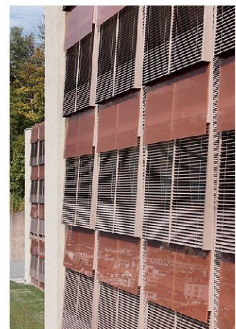
Teilansicht erneuerte Fassade heute (Foto: Ralph Feiner, Malans).
