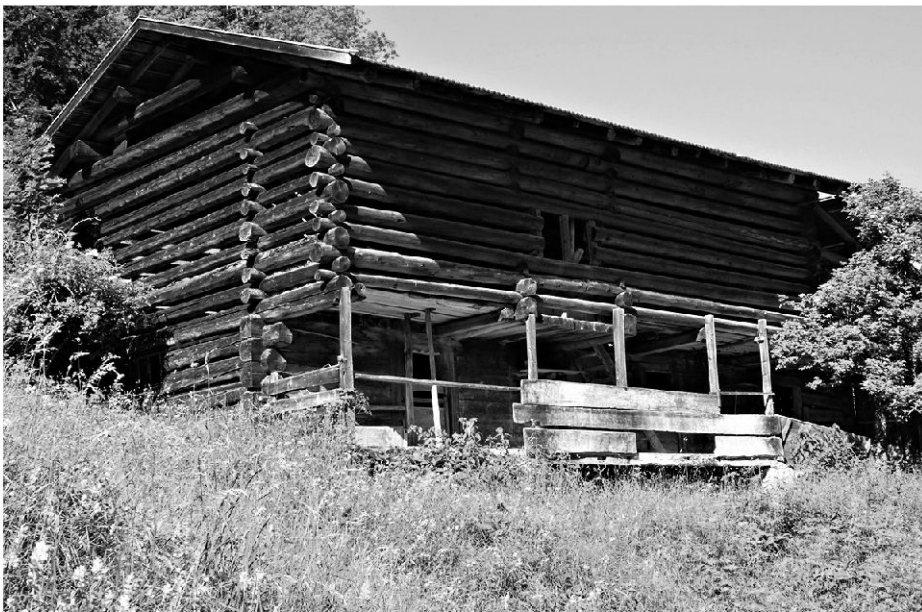
Stallscheune mit Kant- und Rundholzblock in Conters, Unter Cafrida. Auskragendes Obergeschoss mit Dreschente, 18./19. Jahrhundert (Foto: Benno Furrer, 2010).
