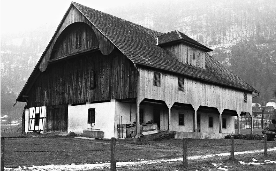
Stallscheune von 1885 mit gemauertem Stallgeschoss und Heuraum in verbretterter Gerüstbauweise. Querhoch-einfahrt und Stallvorlaube. Arth (SZ), Chronenhof (Foto: Benno Furrer, 1986).
