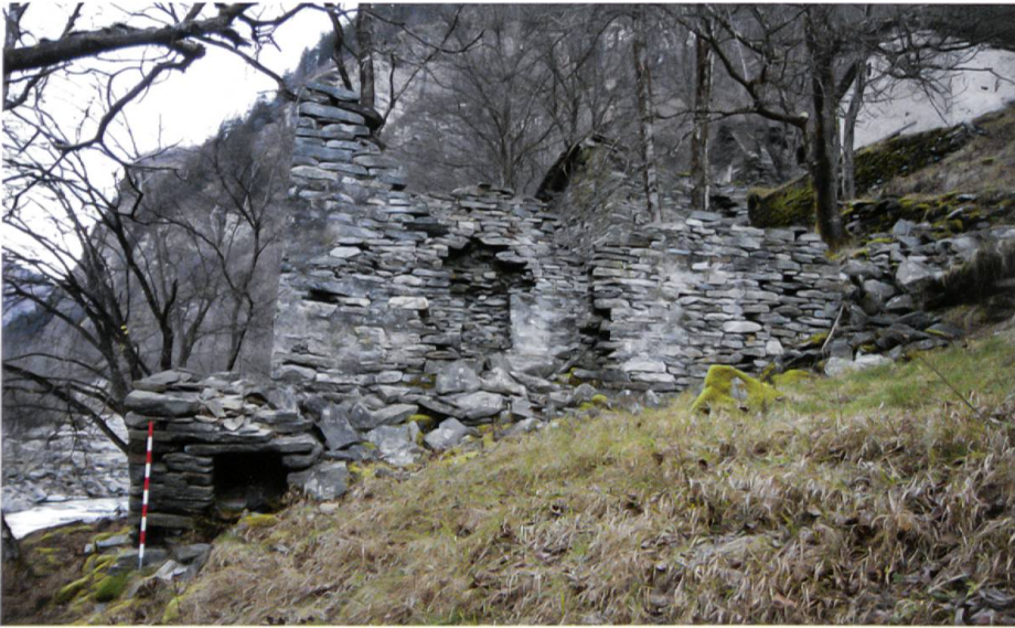
Dapc da Fora, südlich von Arvigo. Ruine eines ehemaligen Wohnbaus mit einem linksseitig, vor die Hauswand gesetzten Backofen (Foto Y. Alther).
