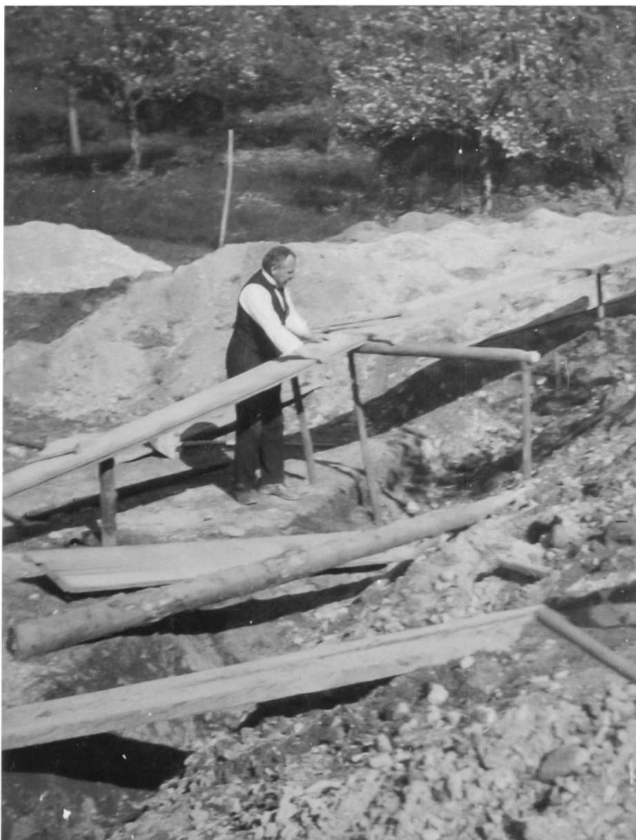
Direktor Blum auf der Schwimmbad-Baustelle im Garglas (Blum).
