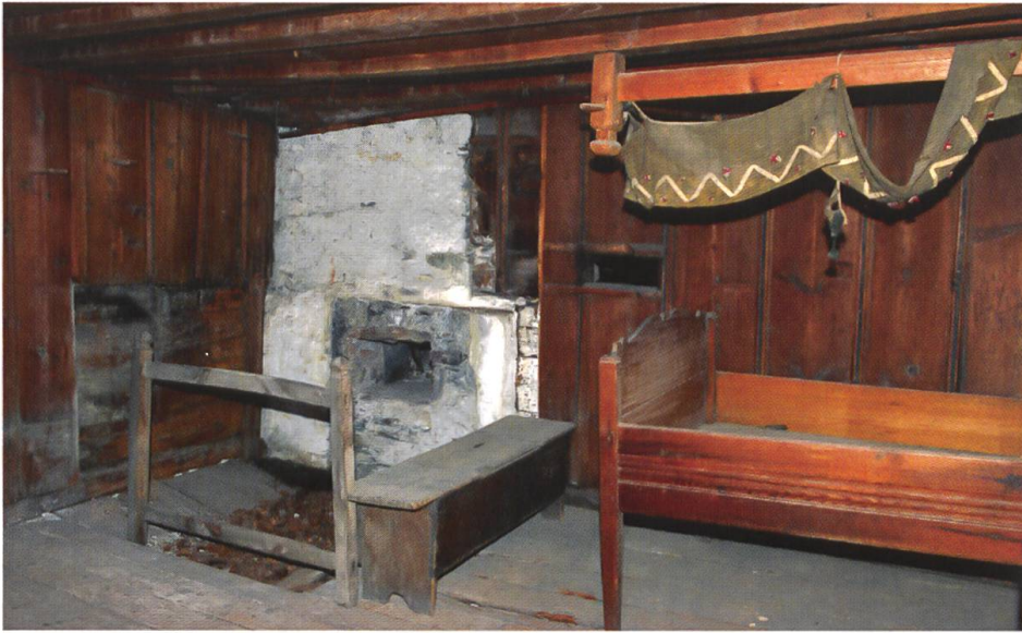
Der Ofen fehlt, dafür gibt es – eine Rarität im Jooshuus – ein Bett: Blick in die Stube im zweiten Obergeschoss, direkt über dem Vorratsraum mit den Korntruhen. Die Balkendecke stammt von 1534.
