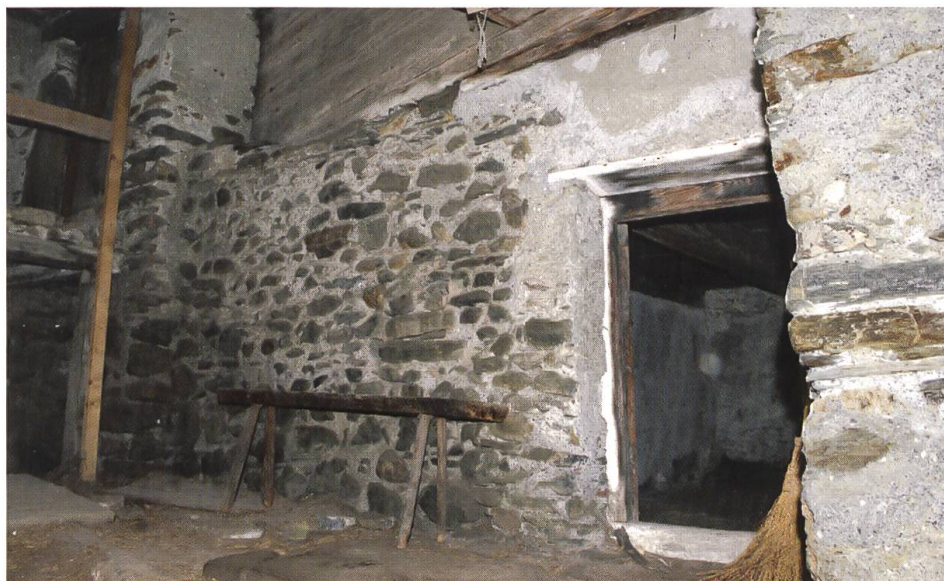
Blick vom Hof aus nach rechts: Unten ersichtlich ist der Zugang zu einem der Keller unter dem Hausteil von 1452. Über dem Eingang zeigt sich die geschlossene Holzstrickwand der spätmittelalterlichen Wohnstube.
