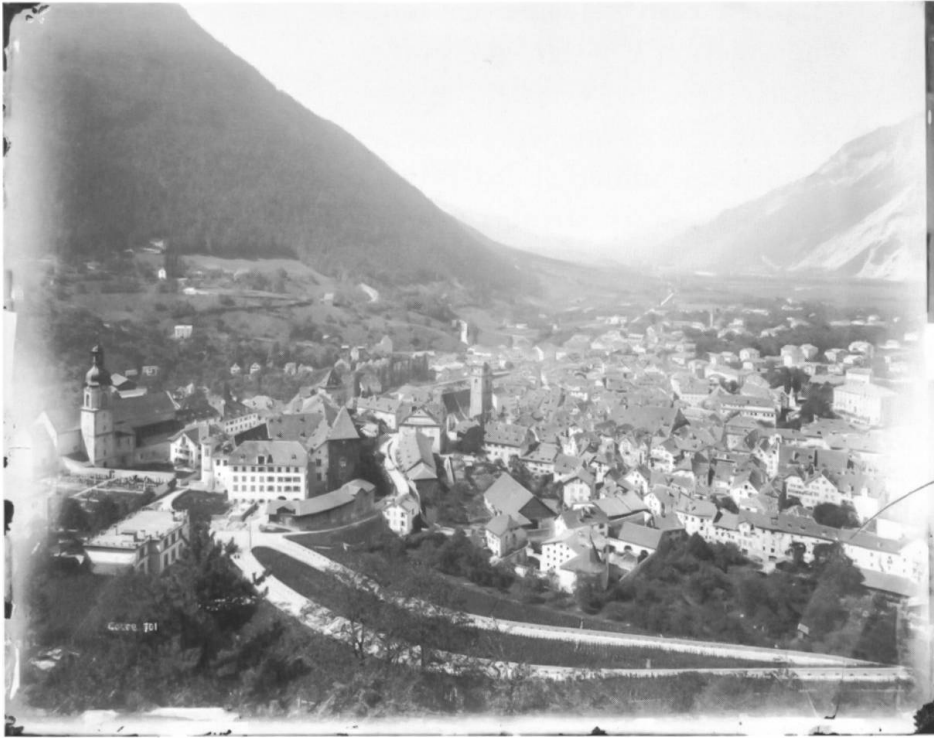
Chur, um 1886. Fotosammlung Lienhard & Salzborn. In der unteren Bildmitte der Sennhofturm mit dem an- und 1851/52 umgebauten, fünfstöckigen Blockhaus. Links vom Blockhaus das «Haus Kratz», rechts davon das Ökonomiegebäude. Hinter dem Blockhaus schliesslich das Haus «Nr° 142» mit den Lokalitäten des Verhörrichters/Polizeidirektors und dem Wohnhaus des Wachtmeisters/Feldweibels als Hausmeister des Sennhofs (StAGR FN IV 24/30 C 001; zur Lokalisierung der Bauten StAGR VIII 5 b 8, Schreiben des Oberingenieurs an die Basler Versicherungsgesellschaft, Chur 16.12.1871).
