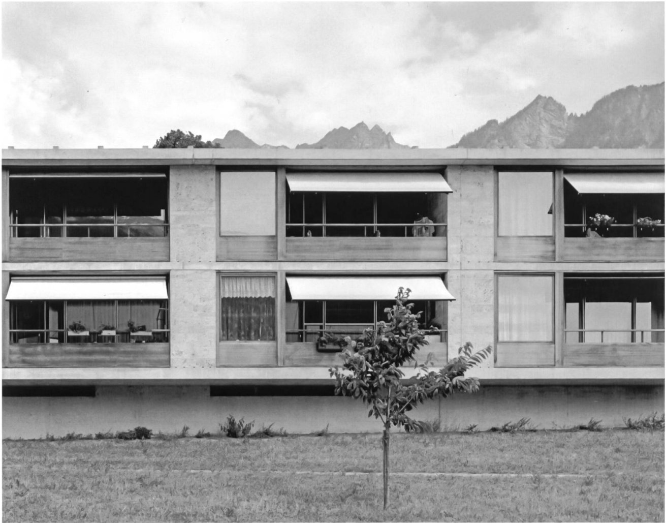
Westfassade (© Hélène Binet).
