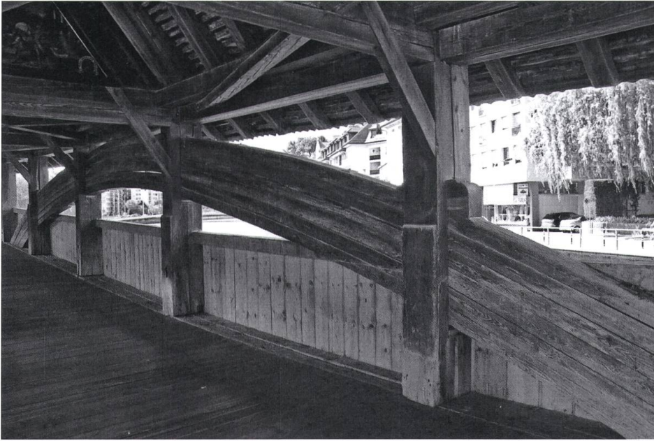
Abb. 2: Bogenträger im von Joseph Ritter errichteten nördlichen Flügel der Spreuerbrücke in Luzern. (S. Holzer, 2017)
