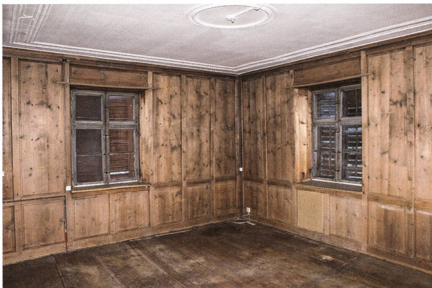
Esszimmer im zweiten Obergeschoss. Die Gipsdecke zeigt eine schlichte biedermeierliche Kranz-Stuckatur mit sich überkreuzenden Stäben.
