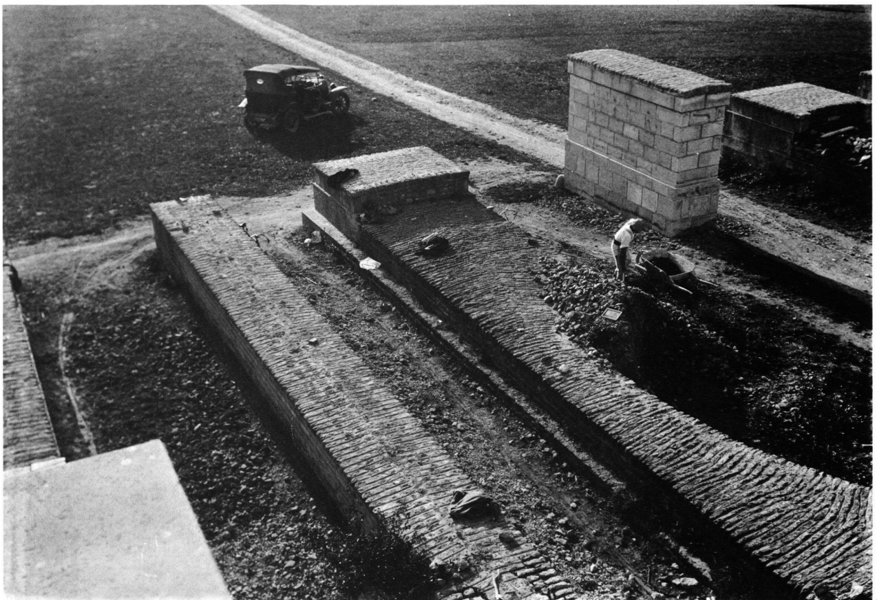
Fig. 9. — Travaux à la porte de l'Est en 1929.
