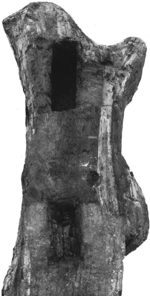
Fig. 23. Porte de Morat. Mortaises à l'extrémité sud de la solive B6.
