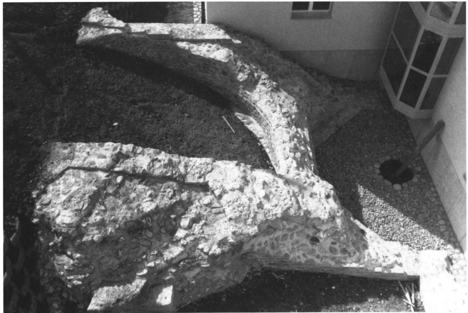
Fig. 30. Le balnéaire de la villa Derrière-la-Tour après restauration. Photo FPA.
