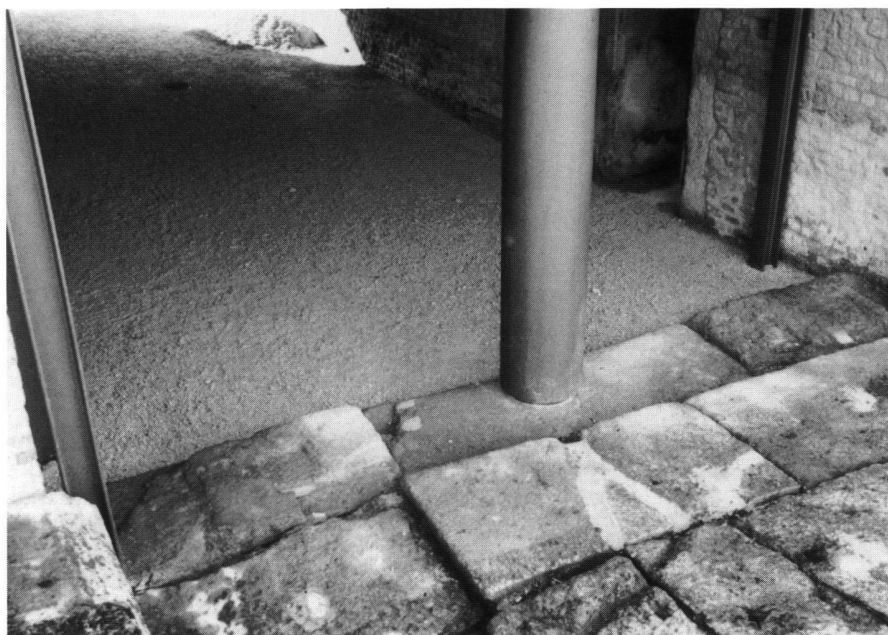
Fig. 13. Avenches, Amphithéâtre. Les trois dalles du seuil de l'entrée axiale et les supports modernes de la façade de la tour du Musée.
