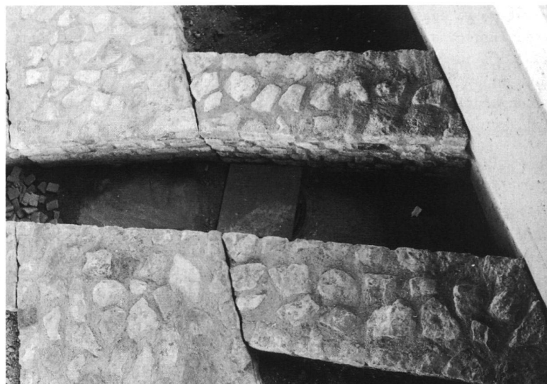
Fig. 19. Avenches / Insula 29, thermes de «Perruet». L'aqueduc au passage du mur nord du frigidarium, vu de l'est. A droite, les piédroits rebâtis et le mur en béton de l'enclos. Le radier d'opus spicatum n'est ici pas encore restauré.
