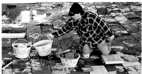
Fig. 6. Réparation du dallage. Pour conserver la position originale de chacun d'eux, c'est dalle par dalle qu'on prélève les éléments dégradés et qu'on pose les nouveaux sur un lit de gravier très fin. Photo MRA.
