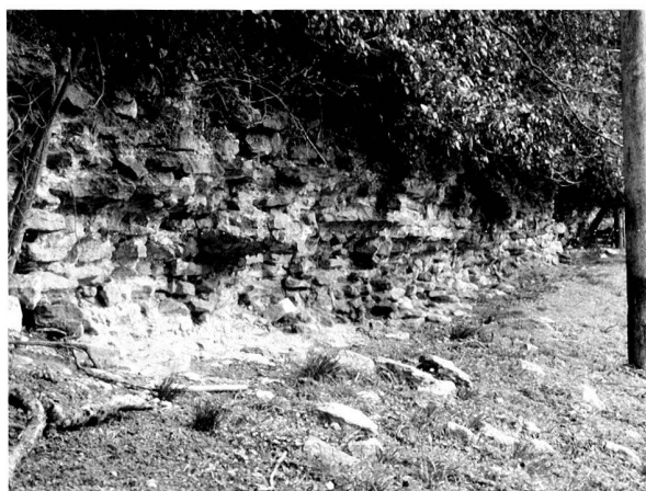
Fig. 4. Le Mur d'enceinte Au Lavoir. Photo MRA.
