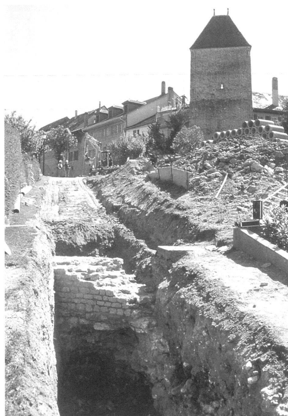
Fig. 27. Avenches/Chemin des Marronniers, enceinte romaine. Vue du sud-ouest, les vestiges, épargnés par les travaux, de la tour 29 du mur d'enceinte. À l'arrière-plan, la tour médiévale du Vully.
