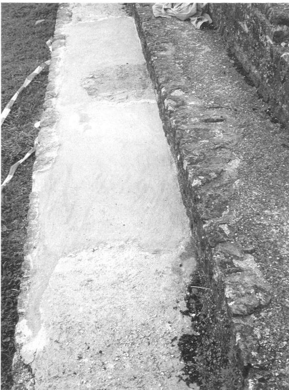
Fig. 5. Portique nord-est du Cigognier : remplacement de la chape du gradin inférieur (photo MRA).
