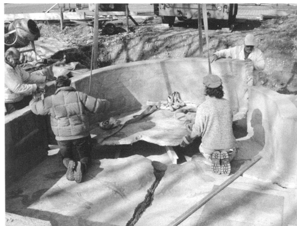
Fig. 13. Münsingen: mise en place des éléments du bassin. Photo MRA.
