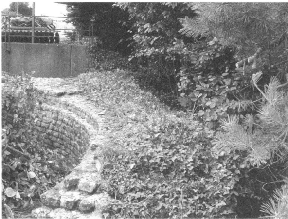
Fig. 7. Porte de l'Ouest. La maçonnerie de la tour nord dégagée des buissons qui l'envahissaient; la végétation tapisante est maintenue en protection du couronnement du mur (photo MRA).
