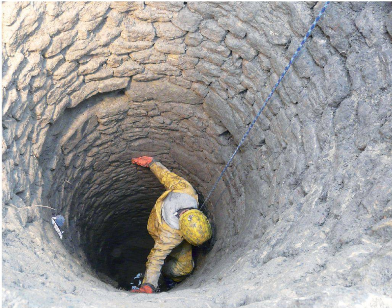
Fig. 21 2010.03. Place de l'Église. Vue de l'intérieur du puits.
