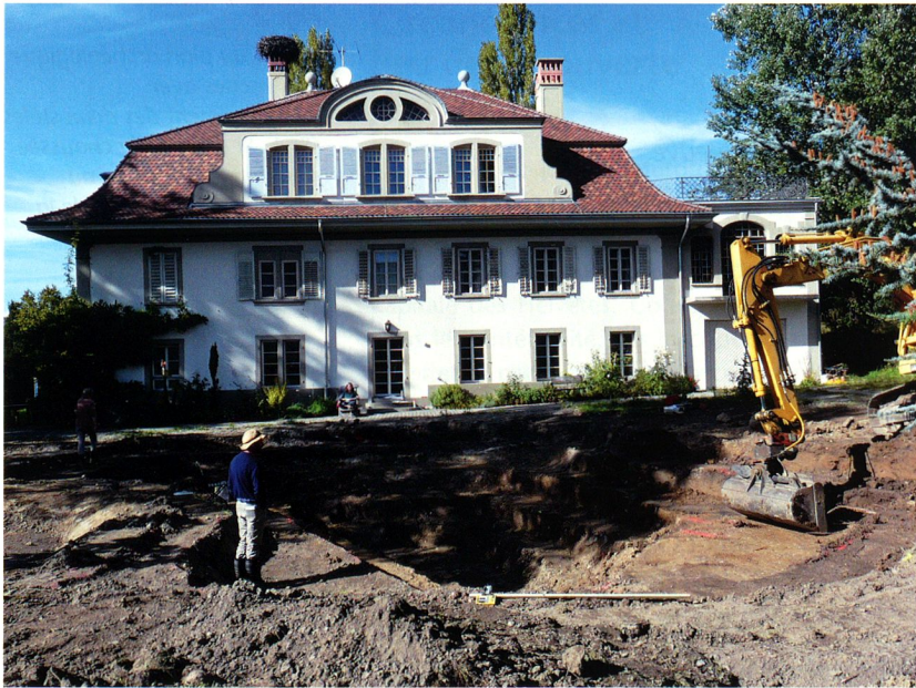
Fig. 4 Travaux en cours devant la façade principale de la maison de la Grange Neuve.
