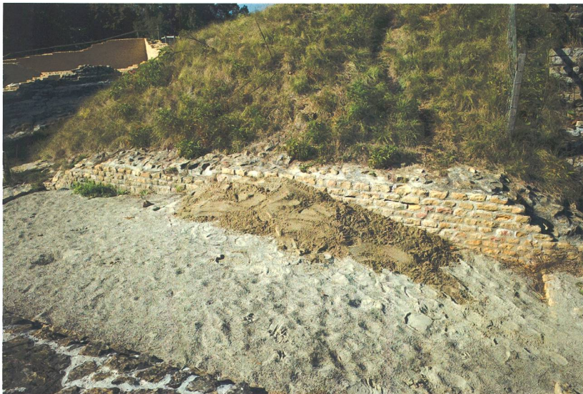
Abb. 19 Theater En Selley, Umfassungsmauern im Südwesten. Zone in Keil 6, zwischen den Peripheriemauern M11 und M22; Sandanfüllung zum provisorischen Schutz der originalen Baureste.
