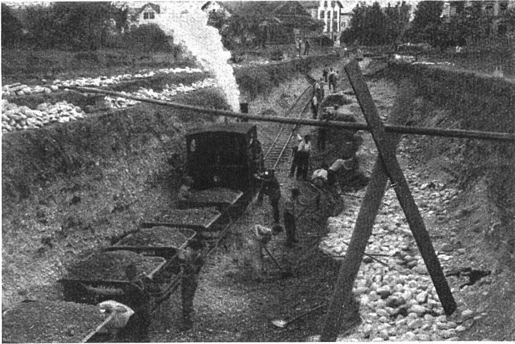
Ausheben der Zufahrtsstraße auf der Brugger Seite.
