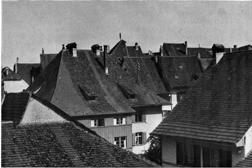
Ueber Dächern und Giebeln Bild vom „Haltwyler“ auf Alt-Brugg
