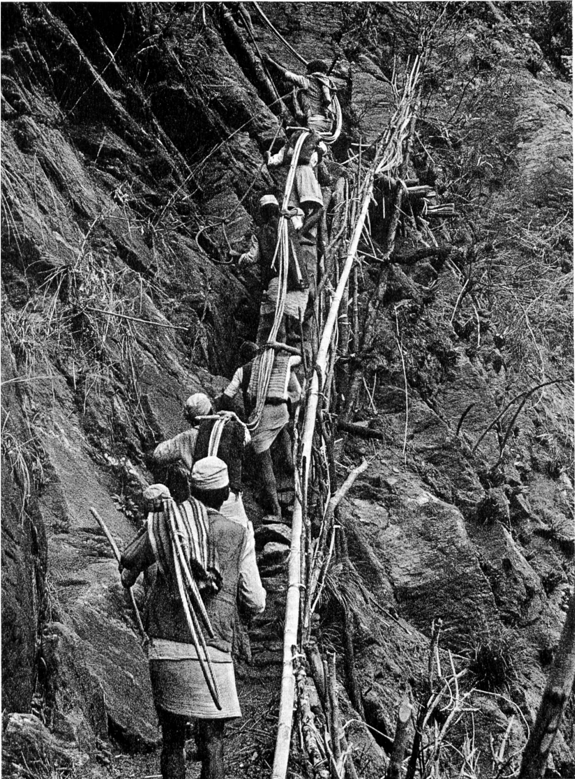
Transport von Seilen für die Marsyandibrücke in der Wand von Jagat, 300 m über dem Fluß
