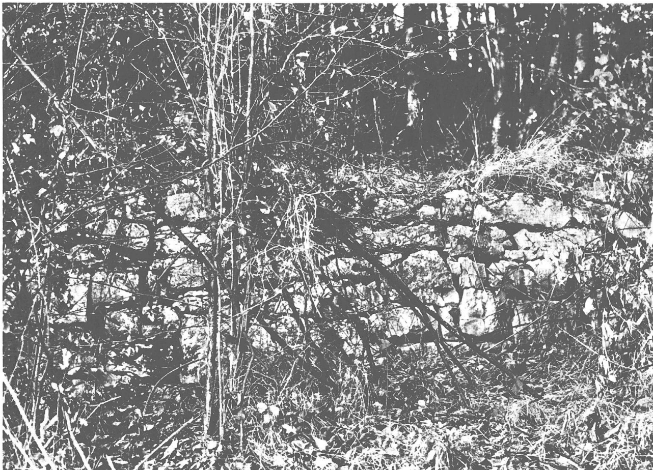
4 Sorgfältig geschichtete Trockenmauer der alten Eitenbergstrasse
