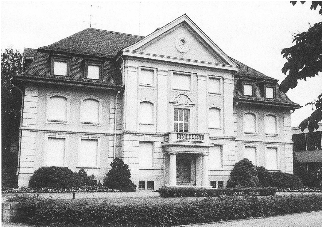
Abb. 15: Verwaltungsgebäude, Spinnerei Kunz Windisch
