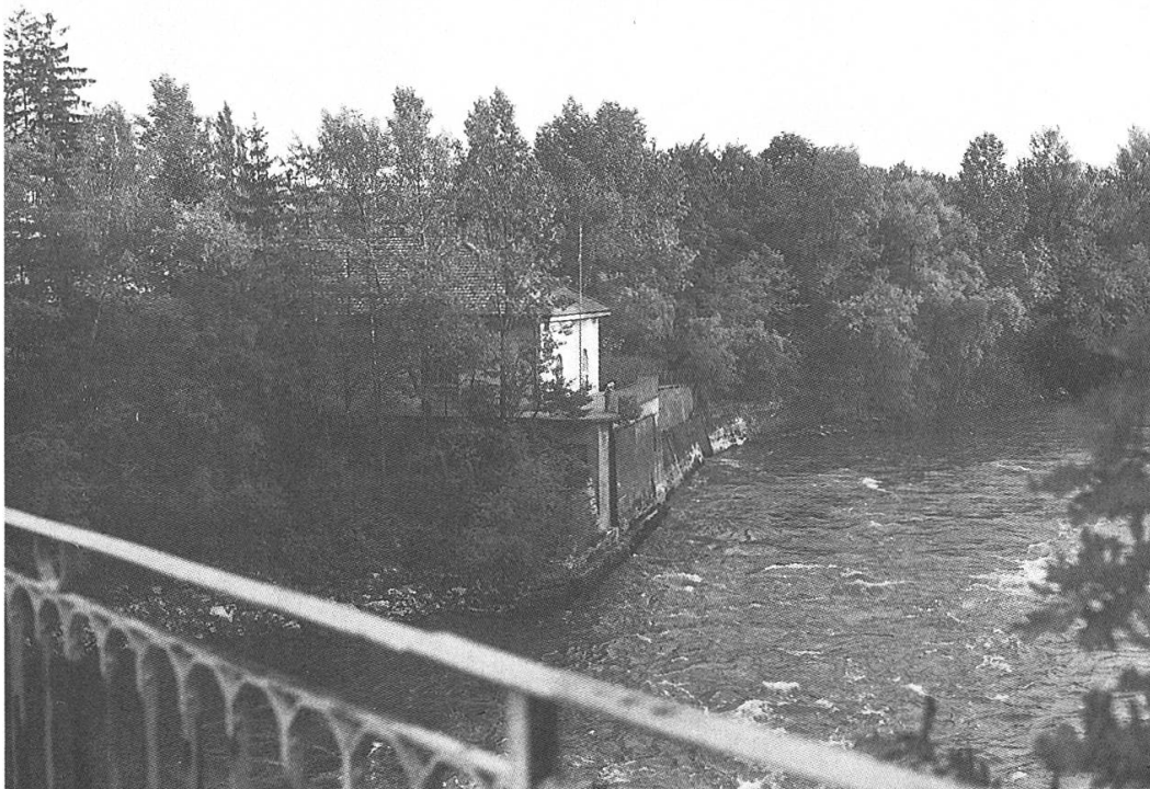
Abb. 10: Versteckt zwischen Bäumen, das ehemalige Kraftwerk Brugg [9].
