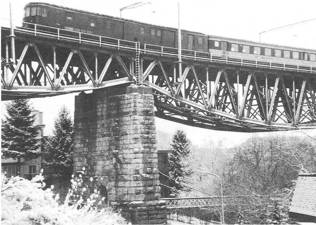
Abb. 3: Ein Objekt von nationaler Bedeutung: Eisenbahnbrücke Brugg/Umiken. Schneebefall bringt oft übersehene Aspekte eines Objektes zum Vorschein.
