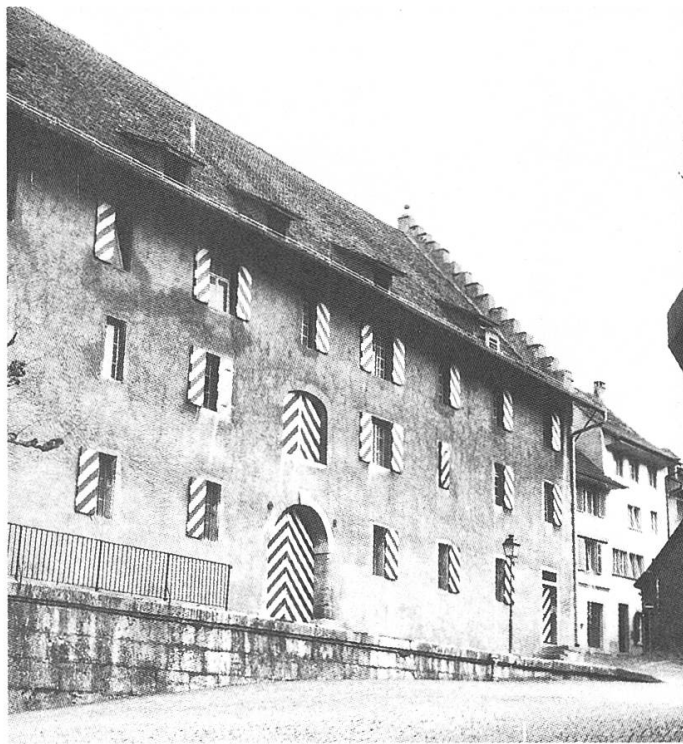
Abb. 9: Ehemaliges bernisches Salzhaus in Brugg.
