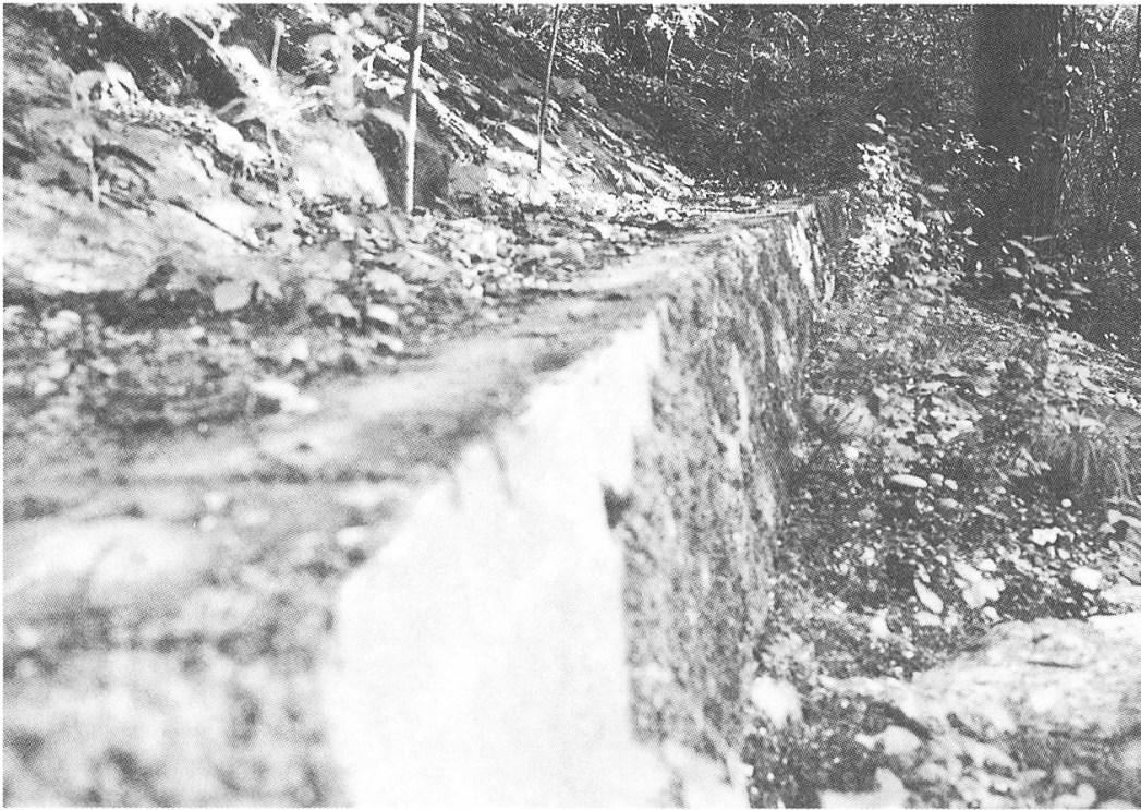
Abb.11: Der aufgefüllte Oberwasserkanal des ehemaligen Kraftwerks Brugg ist heute ein angenehmer breiter Spazierweg. Wer gut beobachtet, sieht zwischen der Aare und dem Weg da und dort noch die Mauer, die einst den Kanal von der Aare trennte.
