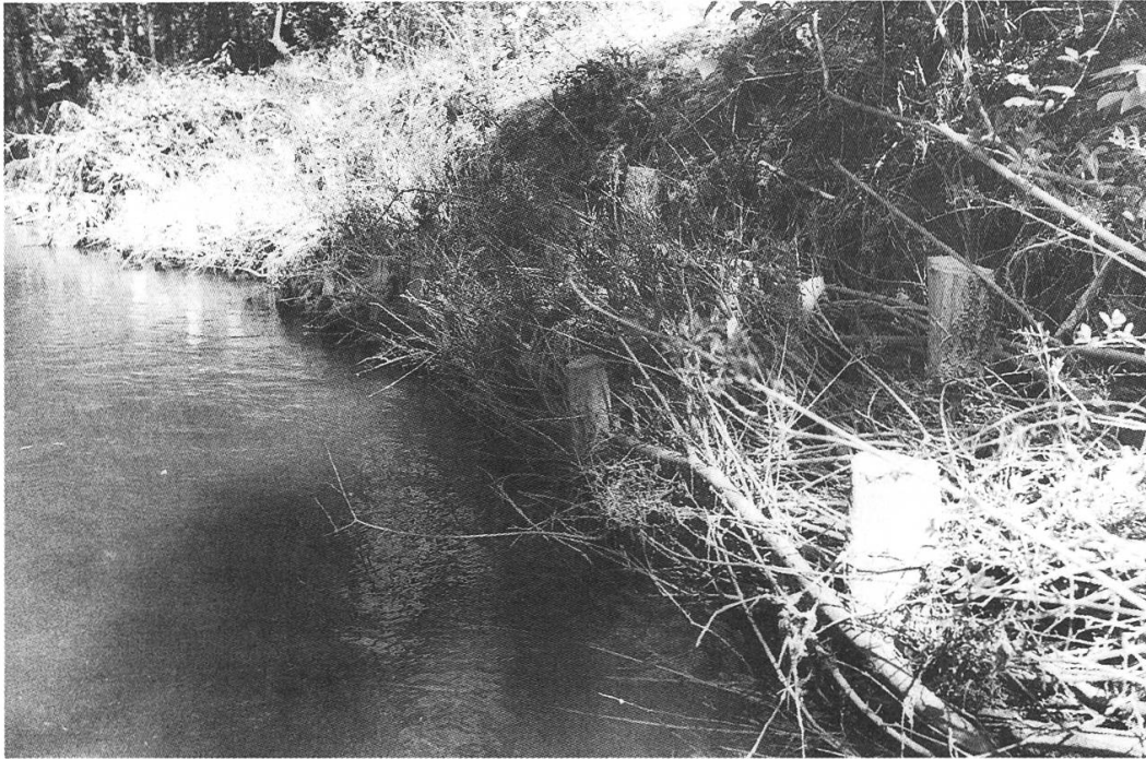
Abb. 8: Astpackungen an der unterspülten Böschung. Astpackungen aus lebenden Weiden und anderem Astwerk werden verpflockt, mit Spanndrähten verdichtet und befestigt. Die Äste fördern die Ablagerung von Sand und Schluff durch eine Verminderung der Fließgeschwindigkeit. Die eingelegten Weiden treiben aus, wobei ihr Wurzelwerk das Ufer vor weiterer Erosion schützt.
