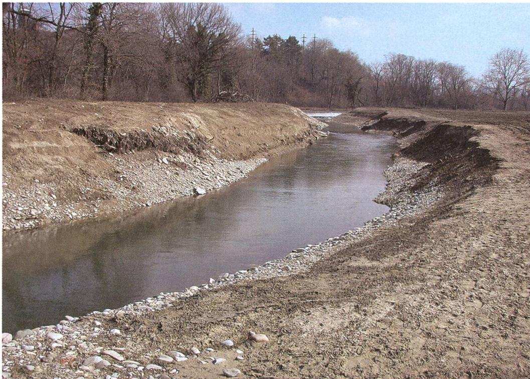
landfläche wurde mit einer einheimischen Blumenwiesenmischung angesät. Entlang den Ufern sind Schwarzpappeln und am Fussweg zwei Heckenstreifen angepflanzt worden. Insgesamt wurden 11 000 Kubikmeter Sand und Kies verschoben oder abtransportiert. Zu diesem Zweck ist die kleine Brücke über den Oberwasserkanal des Kleinkraftwerkes temporär mit Stahlträgern und Stahlplatten verstärkt, beziehungsweise im wahrsten Sinne des Wortes überbrückt worden.
