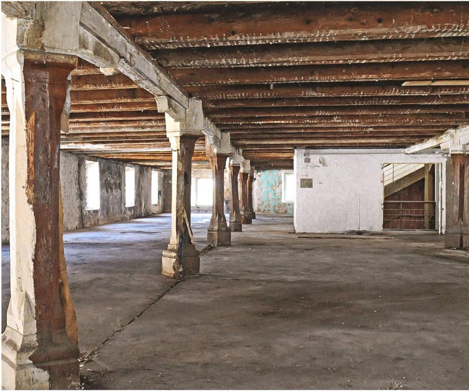
Blick in einen Teil der ehemaligen «Kornschütte» (2. Stockwerk). Die zuvor verdeckte Balkendecke und die eichenen Pfeiler sind wieder freigelegt. Die ganze Halle wurde von zwei weiteren Pfeilerreihen (rechts) getragen. Im Hintergrund das 1927 eingebaute Treppenhaus. Bei Vollbelegung reichte das hier aufgeschüttete Getreide bis zu den Fenstersimsen und musste regelmässig belüftet und umgeschaufelt werden
