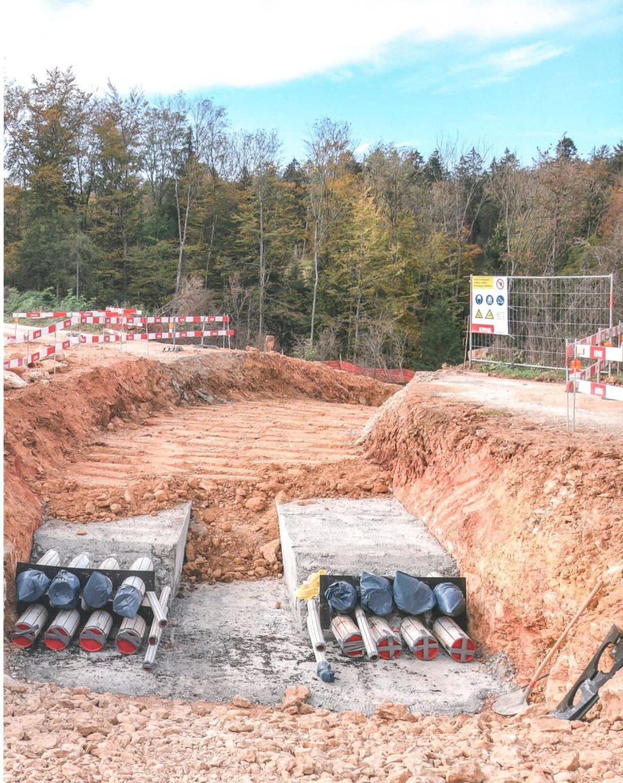
Betonierte Kabelkanäle (Bilder: Swissgrid)
