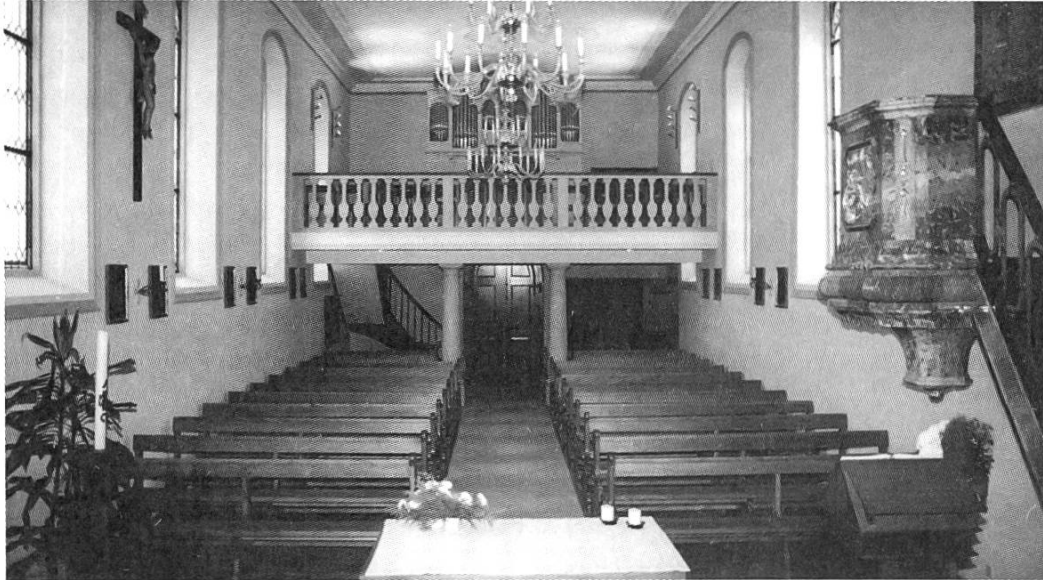
Die Empore verkürzt und tiefer gesetzt, getragen von zwei barocken Holzsäulen
