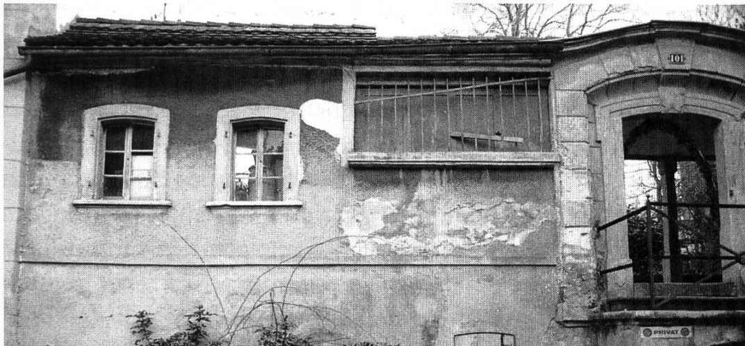
Teilansicht von der Gasse vor der Restaurierung.
