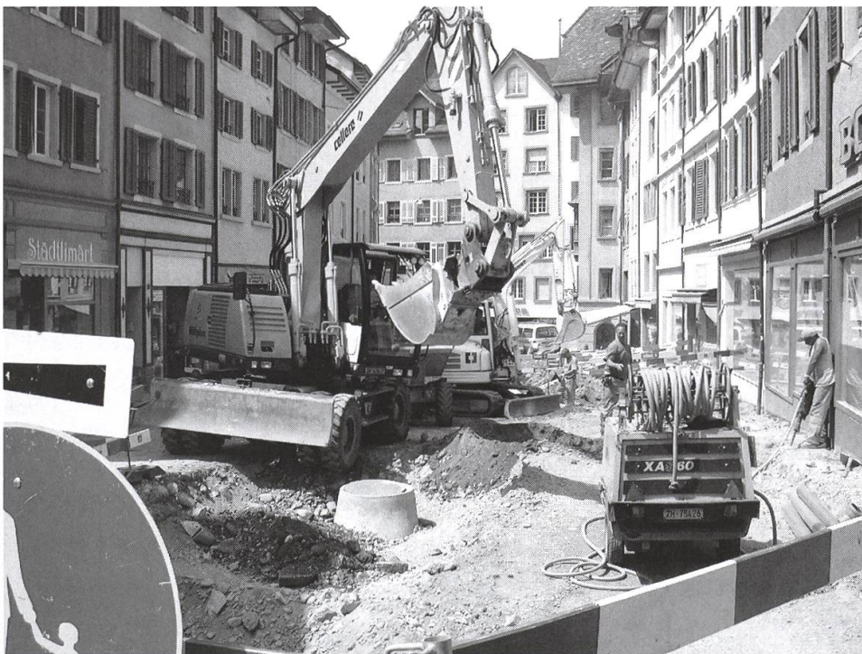
Sanierung und Neupflasterung der Marktgasse. Stand der Arbeiten im Juli 2004.
