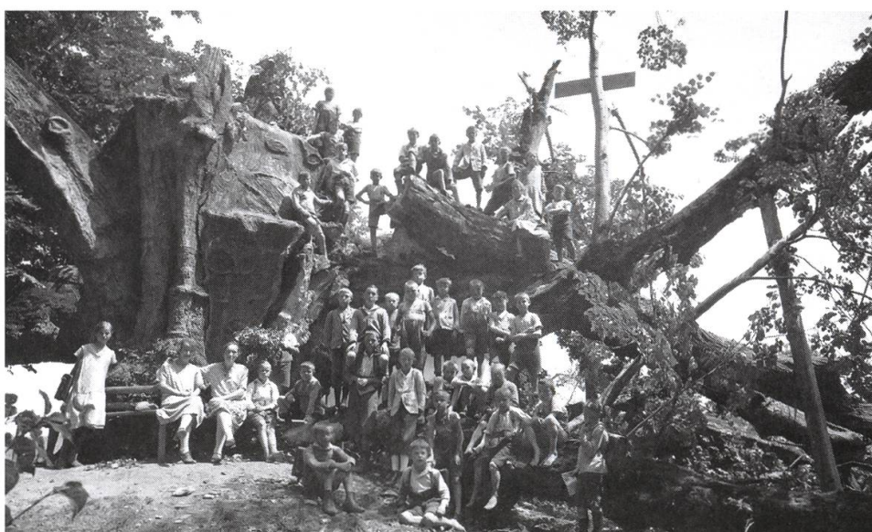
Die Riesenlinde beim Emaus nach dem Zusammenbruch am 7. Juli 1942. Noch sichtbar ist auf dem Bild der riesige Betonkern, der früher einmal in den hohlen Baustamm eingegossen worden war, um die Linde zu stützen.
