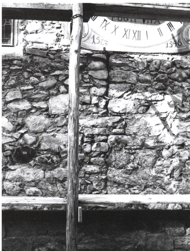
Bei der Renovation von 1982 kam unter dem Verputz auf der Höhe der Sonnenuhr eine Baufuge zum Vorschein. Sie zeigt die Stelle an, ab der die Kapelle um 1676 verlängert worden ist. Foto: Pater Siegfried Müller, Bremgarten.
