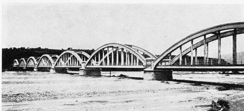
Fig. 12. — Pont sur le Lao à Cosence = Laobrücke bei Cosenza = Bridge over the Lao at Cosenza.
