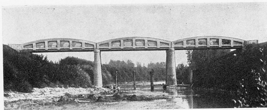
Fig. 8. — Pont de Bondanello sur le Secchia = Secchiabrücke bei Bondanello = Bridge over the Secchia at Bondanello.
