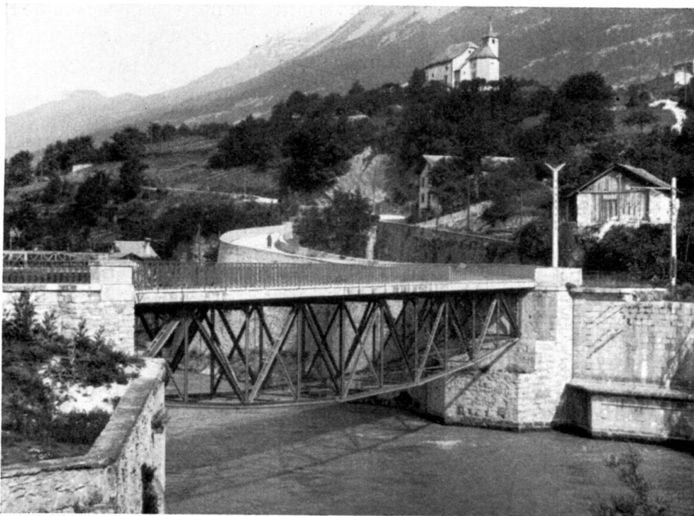
Fig. 6. — Pont-route sur le Rhône à Louèche. Portée 36,9 m. Strassenbrücke über die Rhône in Leuk. Spannweite 36,9 m. Road Bridge over the Rhône near Leuk. Span 121 ft. 1 in.
