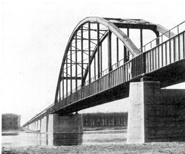
Fig. 17. Elbebrücke bei Festung Dömitz (Stützweite 153,8 m, 1936).
