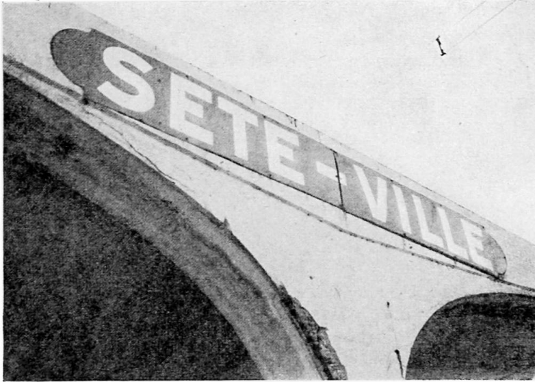
Fig. 12. Abris de la gare de Sète-Ville
