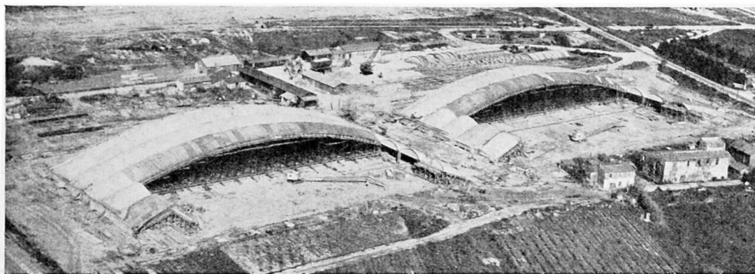
Fig. 26. Vue aerienne en cours de travaux
