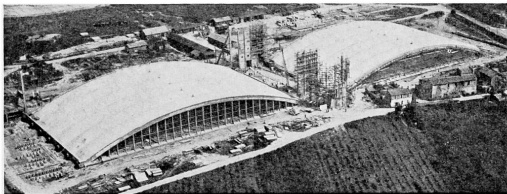
Fig. 27. Couverture prête au levage
