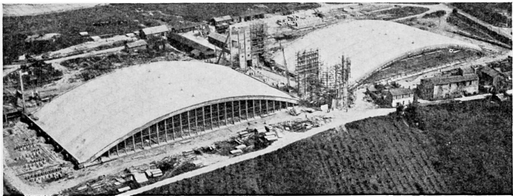
Fig. 27. Couverture prête au levage
