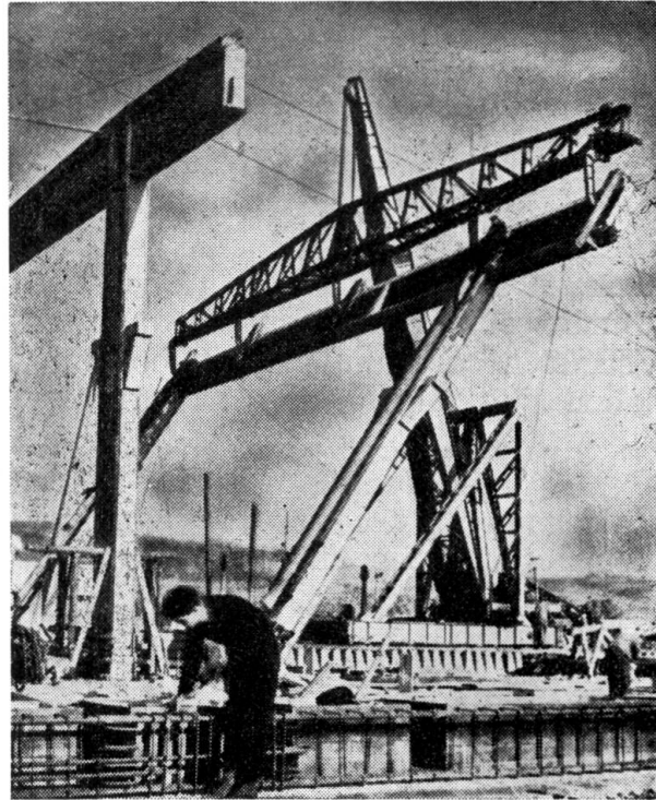
BILD 8. Montage des zweistieligen Rahmens
