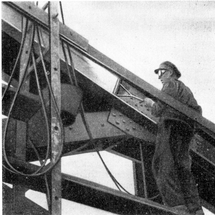
BILD 3. Flammstrahlen einer Brücke. Brennerbreite 300 mm
